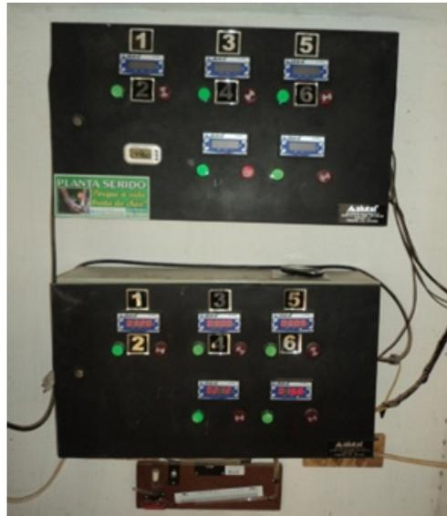
Figura 10. Painel de registro das temperaturas aferidas nos termopares distribuídos na estrutura dos fornos abóbodados
