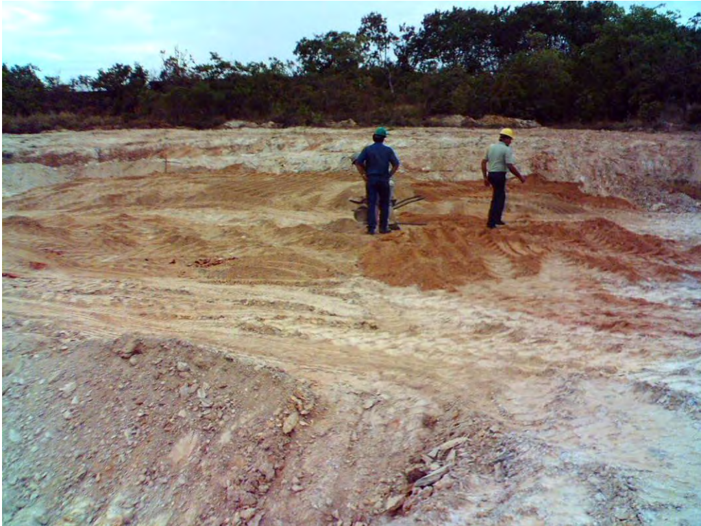
Figura 3.21 - Lançamento da camada de cascalho – barreira capilar.
