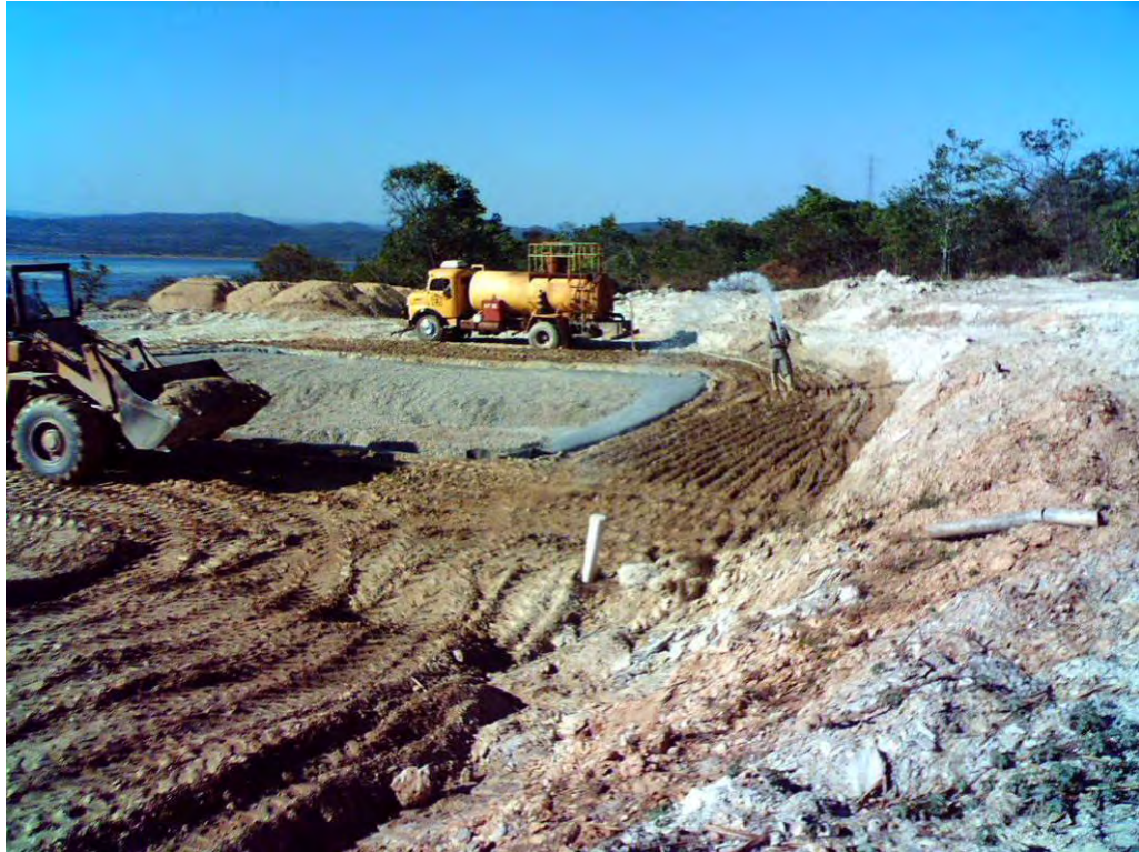
Figura 3.5 - Camada de trafegabilidade/fundação (notar o umedecimento da camada e compactação com a carregadeira).
