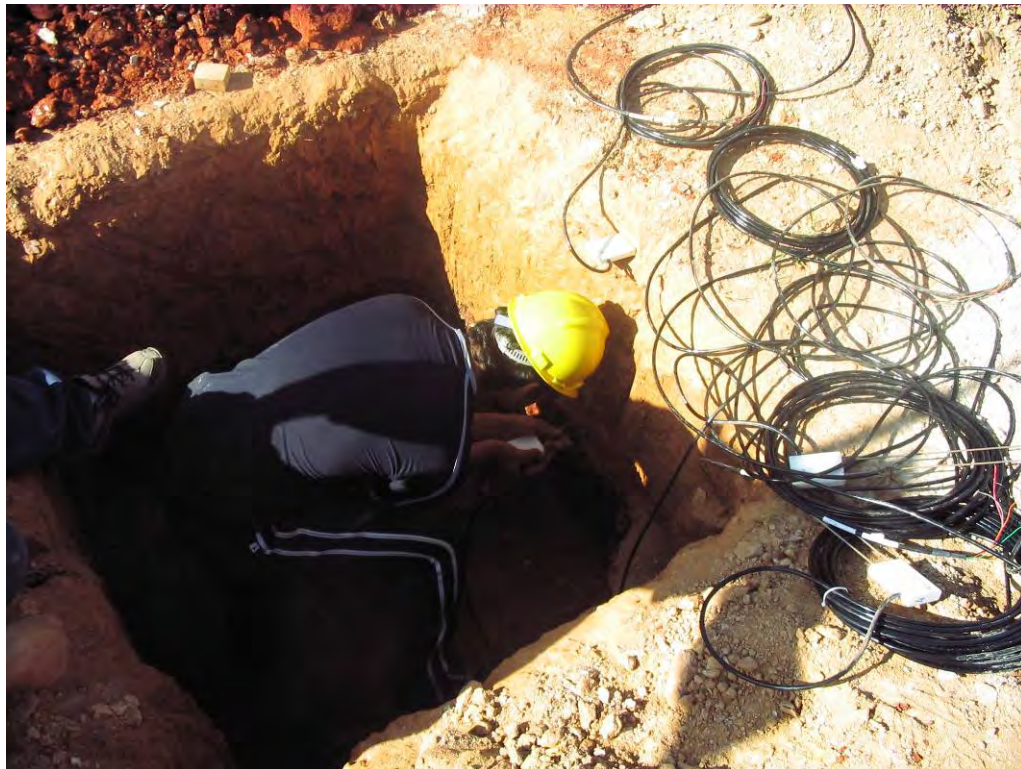
Figura 3.34 - Instalação dos equipamentos na parede do poço, no solo de cobertura.
