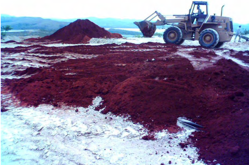
Figura 3.19 - Lançamento e compactação da argila.
