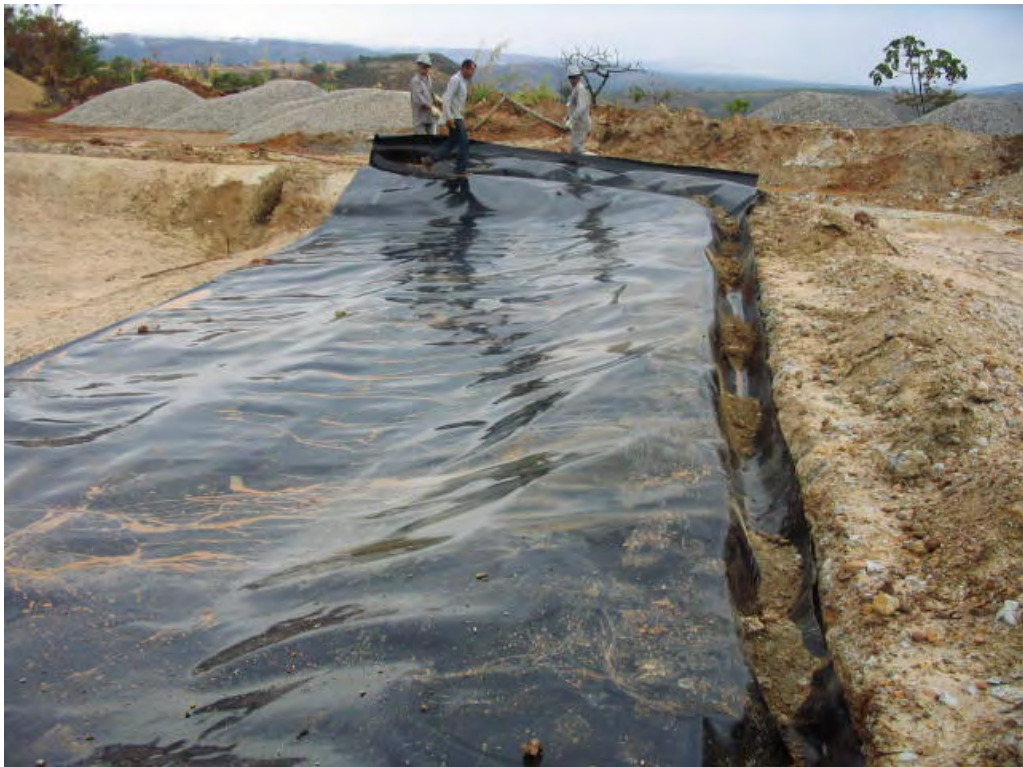
Figura 3.13 - Ancoragem da geomembrana e do geotêxtil.
