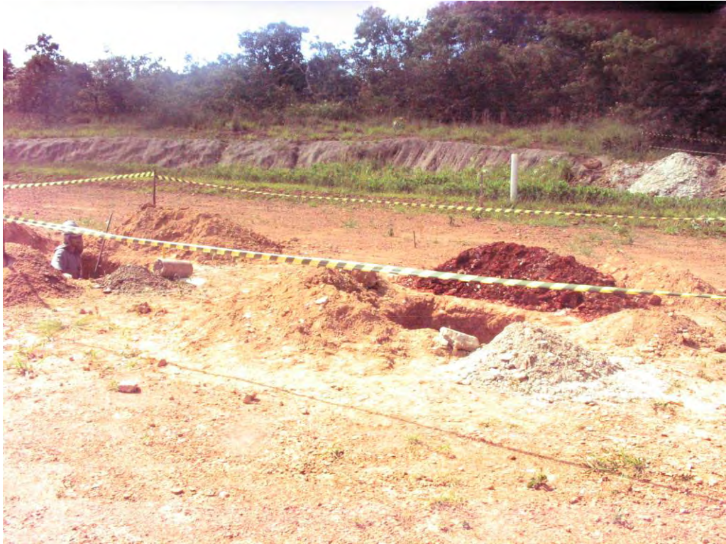
Figura 3.29 - Escavação de poços na cobertura e retirada de amostras indeformadas.
