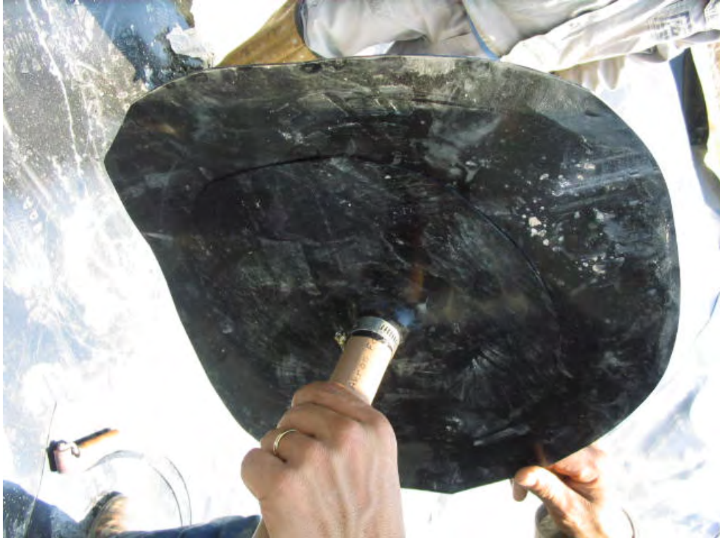
Figura 3.17 - Detalhe da ligação do tubo PVC com a geomembrana (PEAD).
