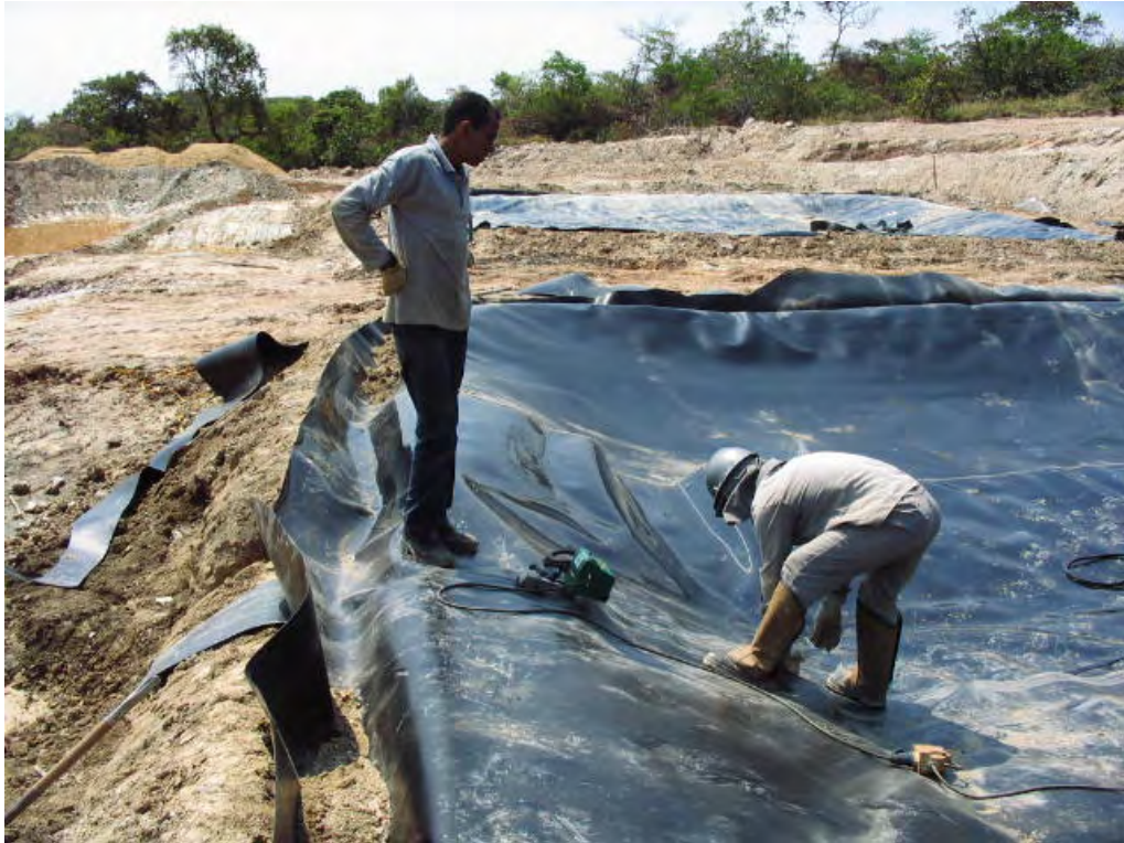
Figura 3.18 - Instalação da geomembrana nos lisímetros e nas paredes laterais (notar profundidade dos lisímetros - parede lateral).
