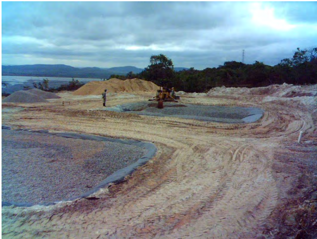
Figura 3.11 - Preenchimento dos lisímetros com brita 1.
