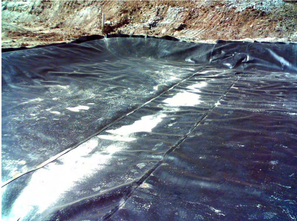
Figura 3.14 - Detalhe da soldagem da geomembrana por fusão.
