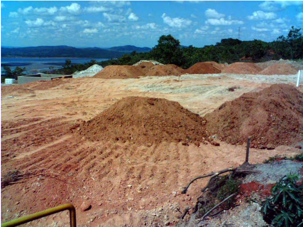
Figura 3.22 - Solo siltoso lançado e início do lançamento do solo orgânico.
