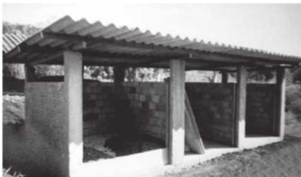
Figura 9 - Modelo de construção de composteira para carcaças.
