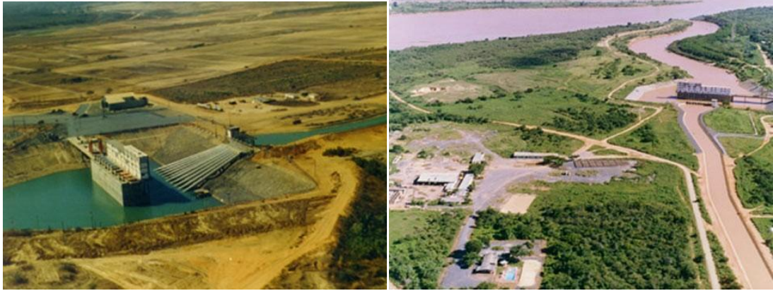
Figura 2.2 – Estação de bombeamento 1 – Vista aérea.
