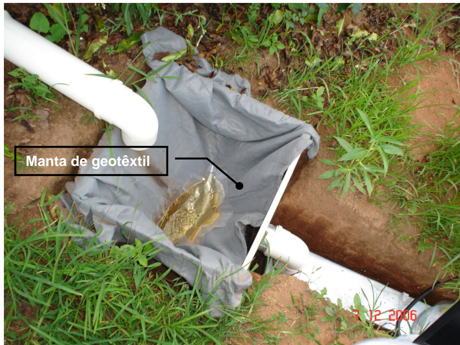
Figura 19 - Sistema de coleta de sedimentos com manta de geotêxtil.
