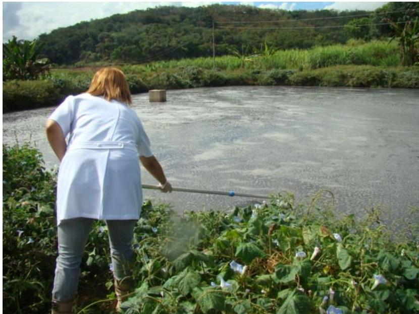
Figura 9. Coleta de amostra na lagoa anaeróbia da granja B.
