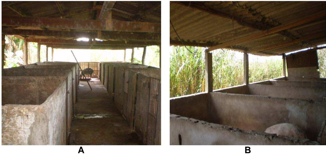
Figura 4. Vista das instalações multiuso suinícola das unidades familiares do Distrito Federal, onde: **A**: Instalação com pé direito baixo; **B**: Instalação com beiral do telhado estreito.
