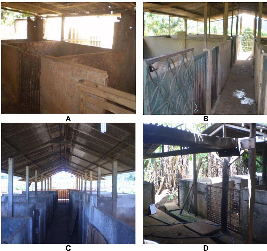
Figura 3. Tipos de construção utilizados nas propriedades familiares, do Distrito Federal, utilizando ou não pilar intermediário onde: **A:** Alvenaria em tijolos, sem pilares intermediários; **B:** Alvenaria em tijolos, com pilares intermediários; **C:** Alvenaria de concreto pré-fabricado sem pilar intermediário e **D:** Alvenaria de concreto pré-fabricado com pilar intermediário.
