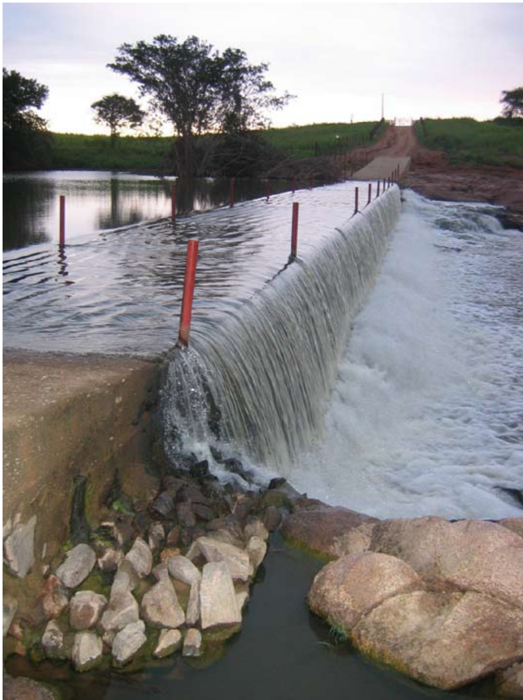
Foto 11 – Barragem com passagem molhada, no rio Umari.
