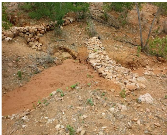
Figuras 2 e 3: Barragem de Base Zero – BBZ no Assentamento Modelo. Fonte: CDJB.
