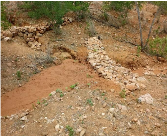
Imágenes 2 y 3: Presa de base cero – BBZ – Asentamiento Modelo. Fuente: CDJBC.
