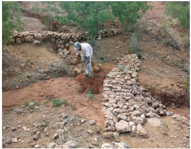
Imágenes 2 y 3: Presa de base cero – BBZ – Asentamiento Modelo. Fuente: CDJBC.
