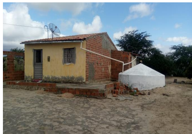
Imágenes 6 y 7: Cisternas de 16.000 l – Asentamiento Modelo. Fuente: CDJBC.
