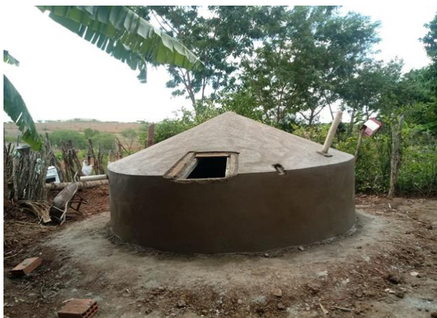
Imágenes 6 y 7: Cisternas de 16.000 l – Asentamiento Modelo. Fuente: CDJBC.
