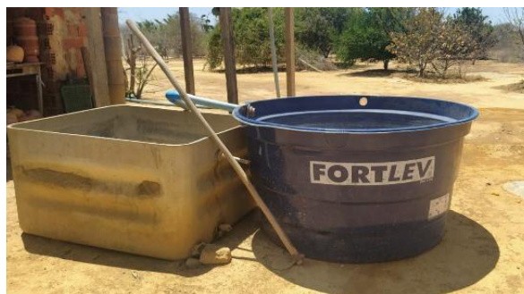
Figura 9: Cajas de almacenamiento de agua
