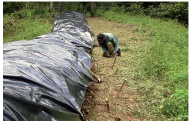
Estaquillado dejando 20 centímetros para la aireación
