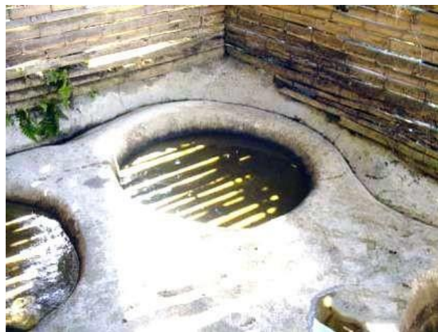
Tanques de suelo cemento
