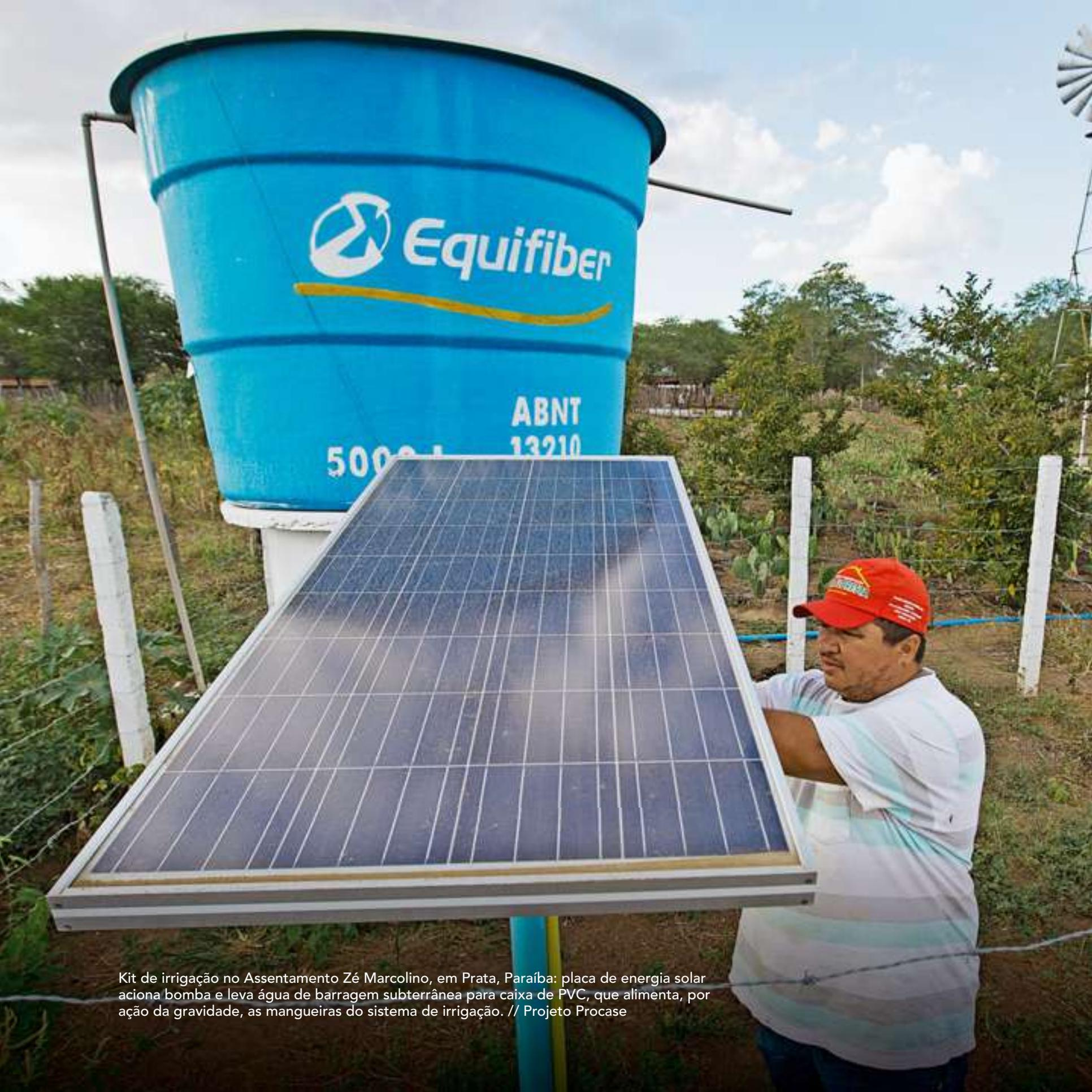
Kit de irrigação no Assentamento Zé Marcolino, em Prata, Paraíba: placa de energia solar aciona bomba e leva água de barragem subterrânea para caixa de PVC, que alimenta, por ação da gravidade, as mangueiras do sistema de irrigação. // Projeto Procasa
