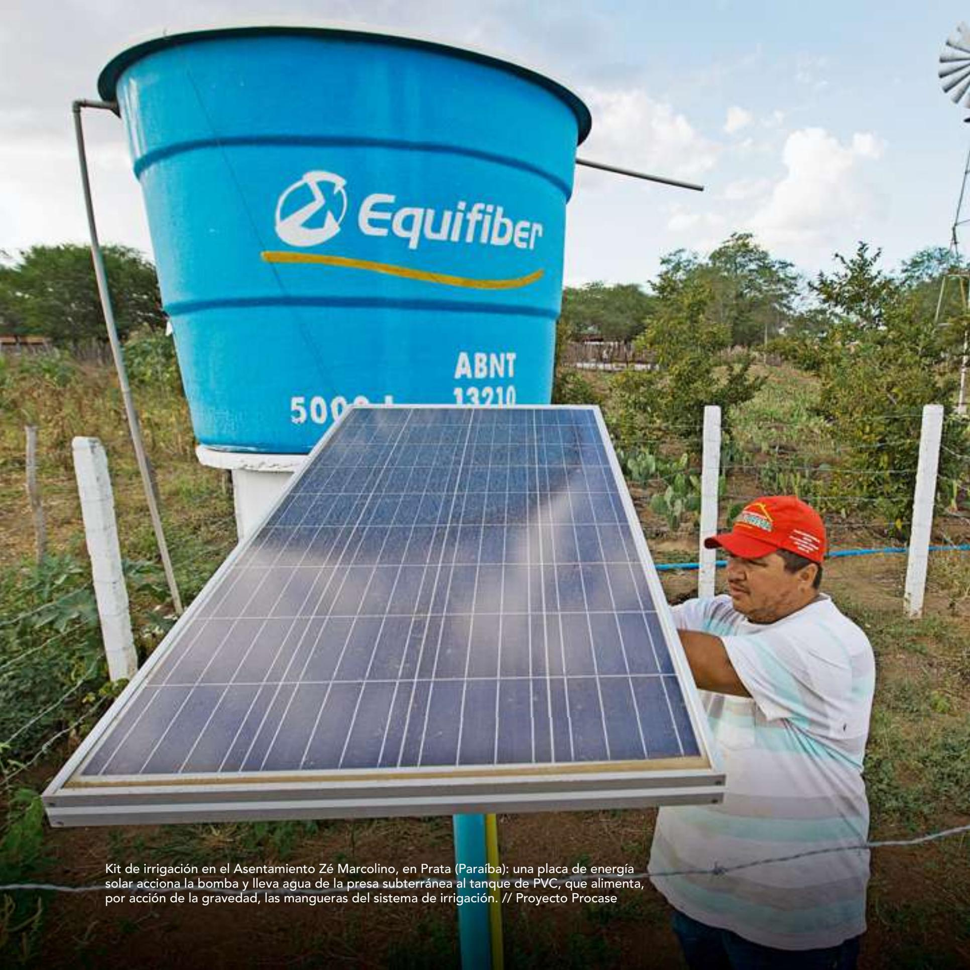
Kit de irrigación en el Asentamiento Zé Marcolino, en Prata (Paraíba): una placa de energía solar acciona la bomba y lleva agua de la presa subterránea al tanque de PVC, que alimenta, por acción de la gravedad, las mangueras del sistema de irrigación. // Proyecto Procace
