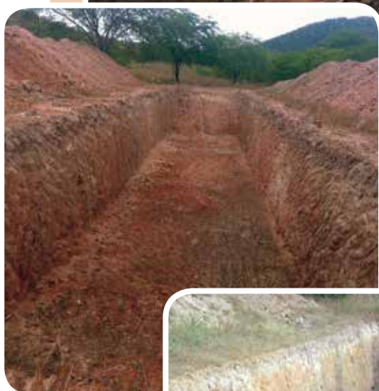
Processo de construção do barreiro trincheira
