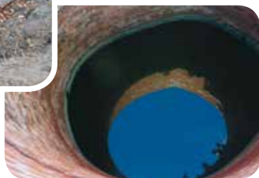
Poço cacimbão em construção
