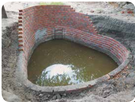
Poço cacimbão em construção
