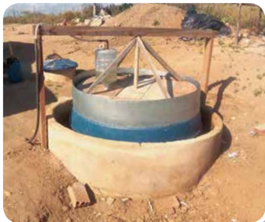
Biodigestor em funcionamento e materiais para confecção das calhas de captação de água de chuva
