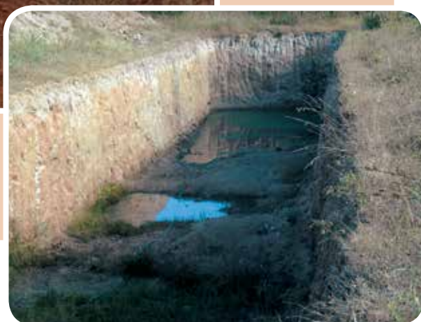
Processo de construção do barreiro trincheira
