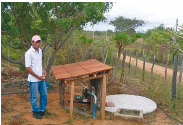
Figura 4: Tanque de reuso com eletrobomba
