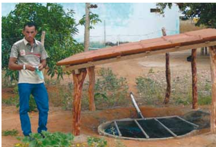
Figura 1: Coberta e estrutura da distribuição de água no filtro
